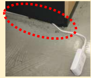
家具類の下敷き状態
